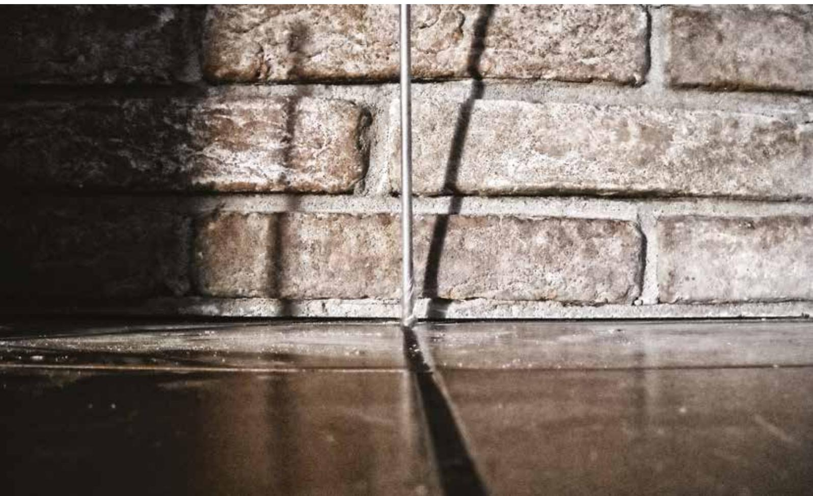
Se realizan pequeñas perforaciones (de diámetro entre 6 y 12 mm) a través de las cuales se introducen una serie de tubos que atraviesan la solera asentada hasta la profundidad necesaria. La malla de perforación de la solera es de 1,00 x 1,00 m., teniéndose en cuenta tanto las condiciones del lugar y de sus posibilidades operativas (obstáculos, presencia de instalaciones enterradas, espesor de la solera etc.) como las peticiones expresas por parte del cliente.
